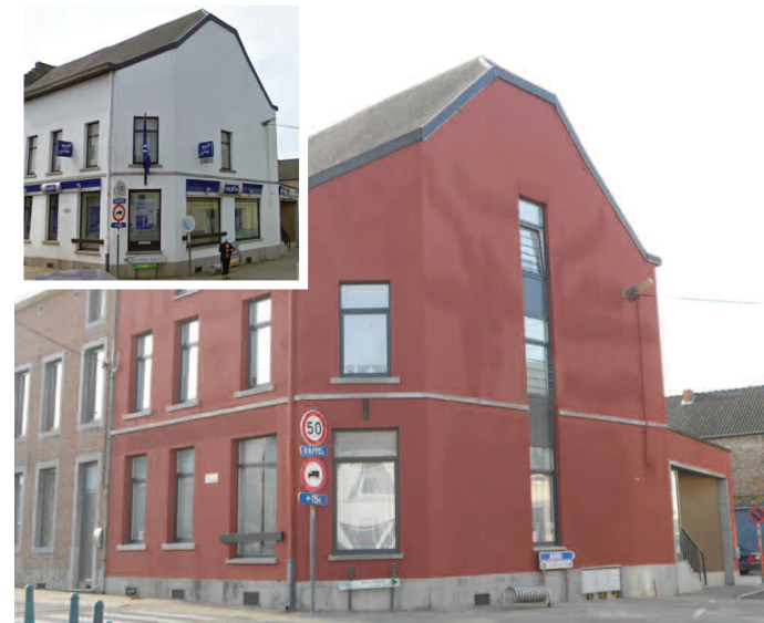
Aménagement d'un ancien rez-de-chaussée commercial et recomposition de la façade
